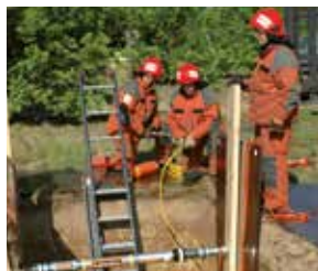
-ratownictwo w wykopach
